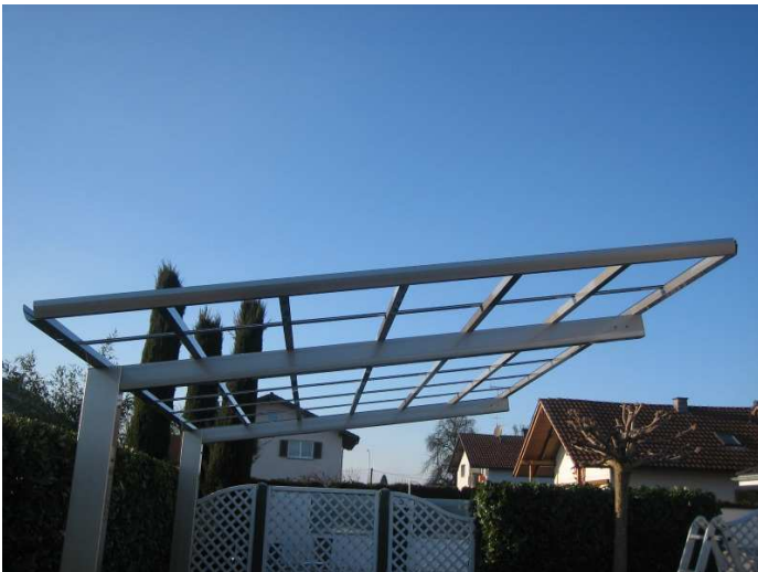
Bild 11: Montage der Querleisten
