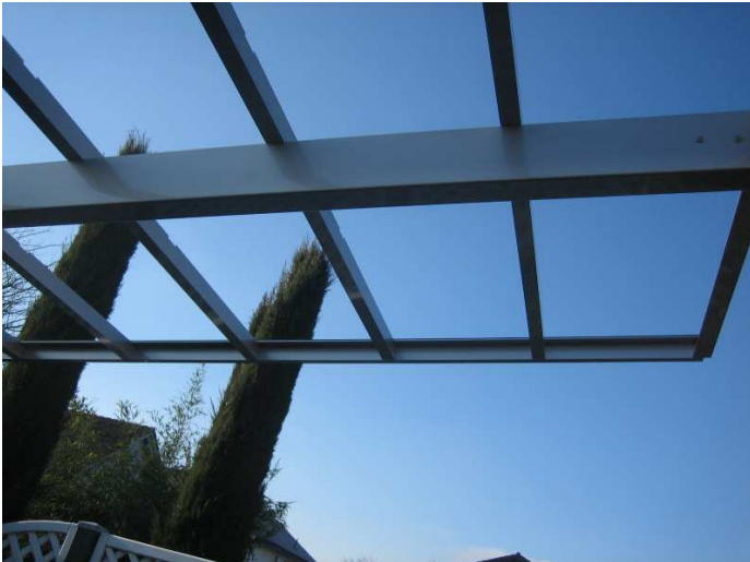
Bild 9+10: Montage der Seitenprofile
