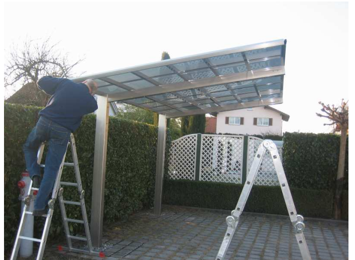
Bild 12: Montage der Abdeckungen
