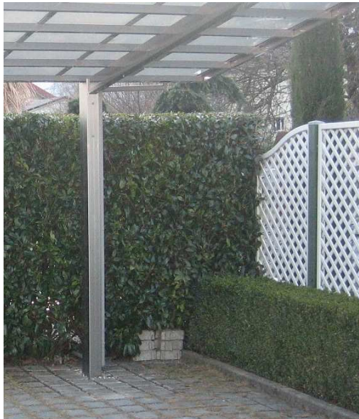
Bild 14: Montage des Regenrinnen – Ablaufes
