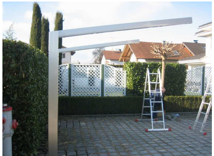
Bild 6: Montage der Dachträger
