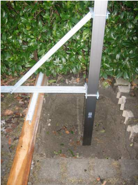
Bild 3 + 4: Beton einbringen und ca. 2 Tage aushärten lassen
