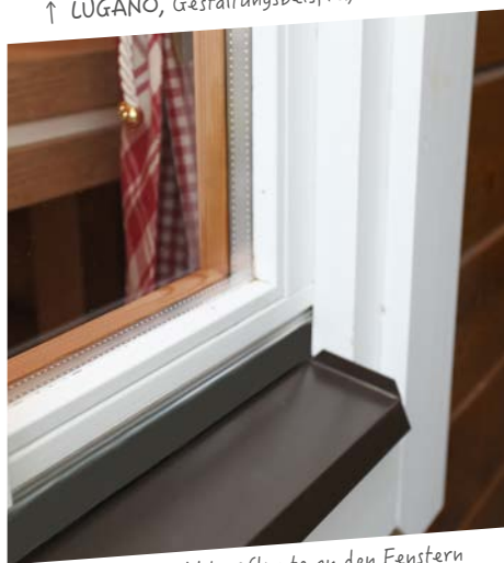
↑ Aluminium-Abtropfkante an den Fenstern
